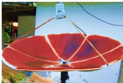
**Gambar 1. Antena parabola yang berkarat/korosi**
