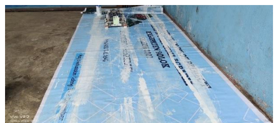
Gambar 20. Pengecatan marka jalan tengah, garis putus putus
