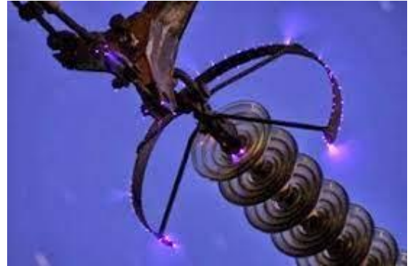
Gambar 5. Gambaran Lompatan listrik / Korona Listrik
