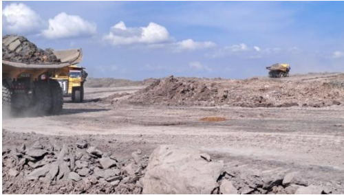
Gambar 3. Jalan Tikungan yang Tidak Sesuai Standar
