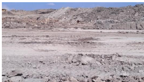
Gambar 2. Geometri Jalan Lurus pada Titik 26 yang Tidak Standar
