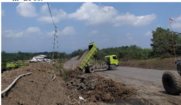
Gambar 6. Kegiatan Dumping Material Pelapisan Ulang BP200 dan BP60
