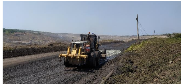
Gambar 7. Kegiatan Grading Material BP200 dan BP60 di Jalan AWR Pit 1
