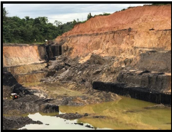
Gambar 2. Situasi Lereng Setelah Terjadi Longsoran
