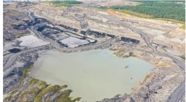
Gambar 8. Sump di Pit Majapahit
