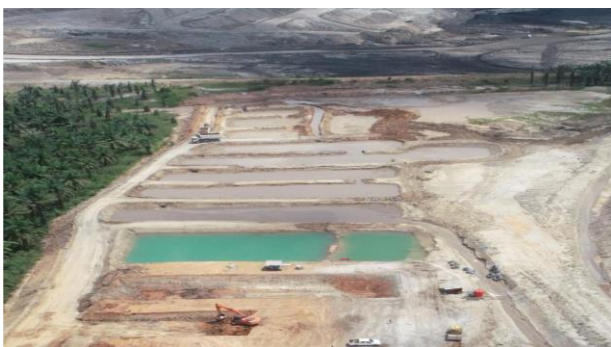
Gambar 12. Kolam Pengendapan Lumpur
