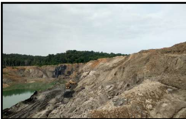
Gambar 15. Kondisi Longoran Pada Lereng
