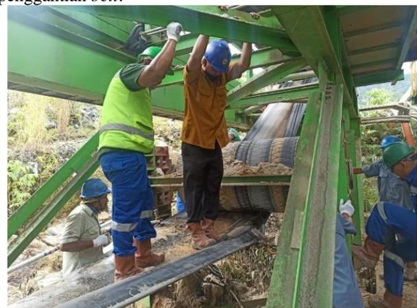
Gambar 9. Perbaikan pada *belt* yang mengelip
