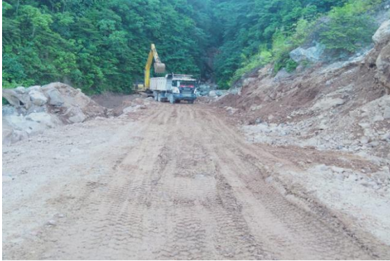
Gambar 1. Akses jalan pada saat belum musim hujan
