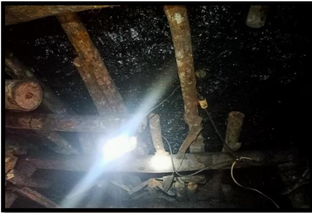
**Gambar 5. Pemasangan atap penyangga yang kurang baik**
