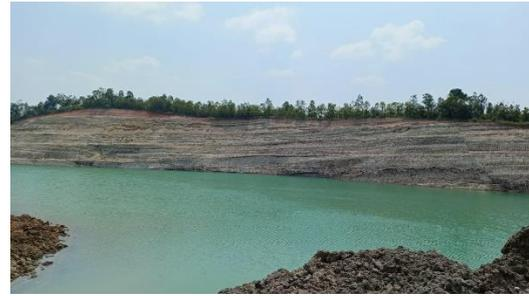
Gambar 19. Kolam Pengendapan Lumpur (*Settling pond*)
