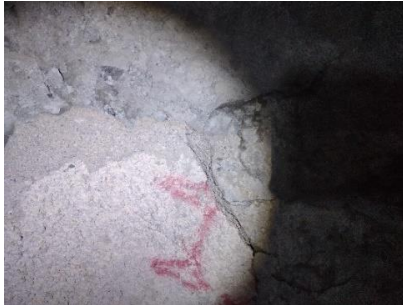
Gambar 2. Penyangga Shotcrete K-400 Pada Terowongan 11
