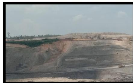
**Gambar 17.** Area Longsor pada *Pit Section 2* Timur
