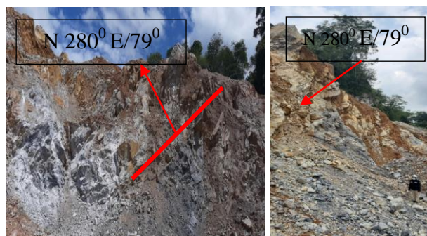
Gambar 1. Kondisi Lereng Pada Area Blok Puncak II CV. Tekad Jaya
