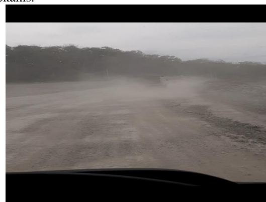
Gambar 6. Kondisi Jalan Angkut Berdebu
