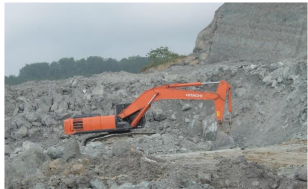
Gambar 3. Excavator menunggu Dump Truck
