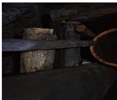
Gambar 1. Retakan pada Kayu Penyangga
