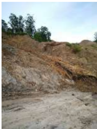
Gambar 4. Longsoran Yang Terjadi Di Lokasi Penelitian
