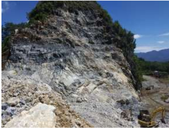
Gambar 1. Kondisi Lereng pada Lokasi penambangan CV. Tekad Jaya
