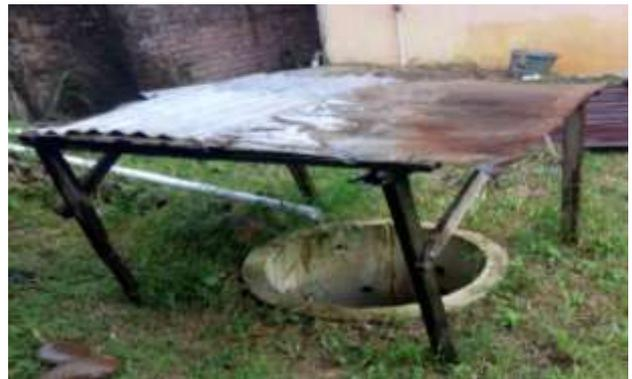
Gambar 4. Sumur Resapan Talang Air
