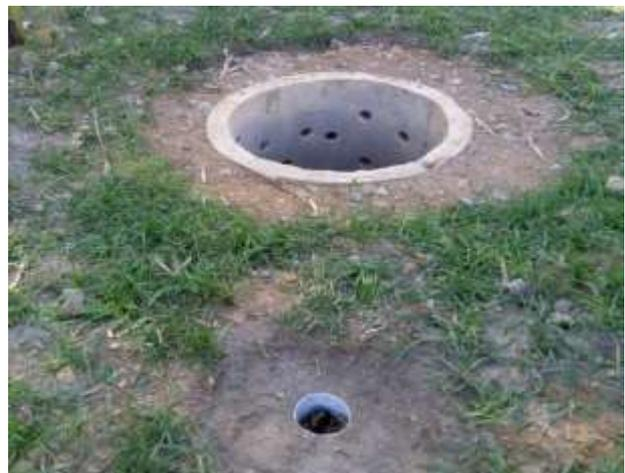
Gambar 8. Sumur Resapan Terbuka
