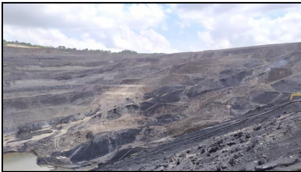
Gambar 2. Kondisi Sidewall Blok Timur Tambang MTBU
