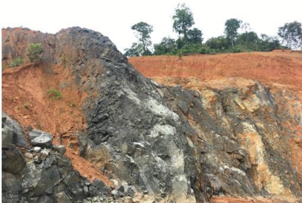
Gambar 1. Kondisi Lereng di PT. ATC 1
