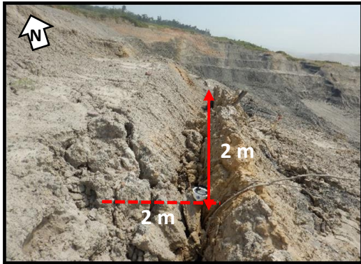
Gambar 1. Crack di Penampang A pada elv. +100 mdpl
