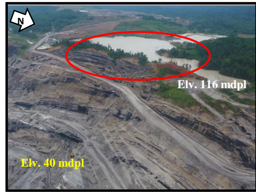
Gambar 7. Kolam ( pond ) pada crest overall slope
