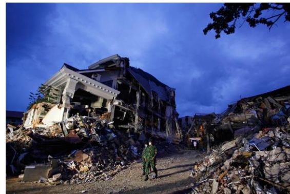
Gambar 12. Kerusakan Bangunan Akibat Gempa 30 September 2009 di Sumatera Barat
