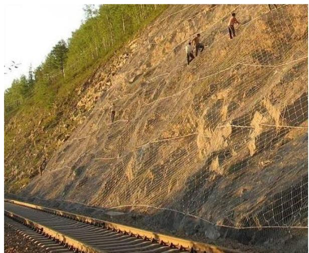
**Gambar 10.** Contoh Pemasangan Wiremesh pada Lereng Batuan
