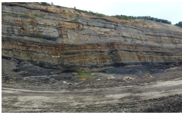
Gambar 1. Kondisi Lereng di Pit Barat PT. AICJ
