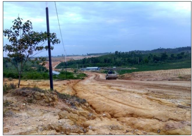
Gambar 2. kondisi jalan angkut
