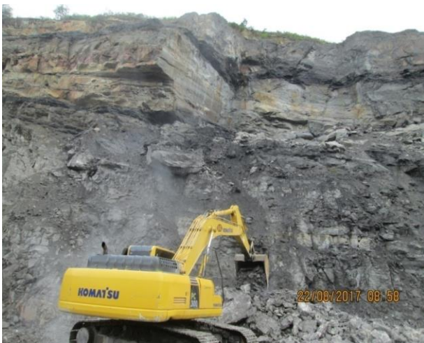
Gambar 2. Lokasi Loading Point
