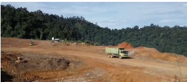
Gambar 3. Dua dump truck pembawa material clay
