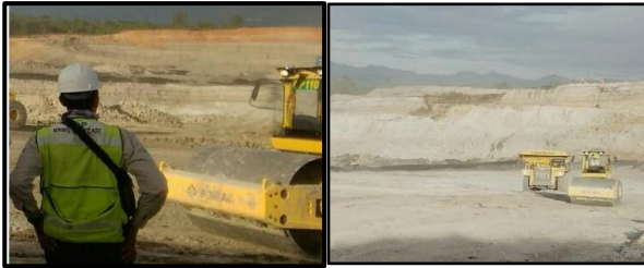
Gambar 19. Pematatan Jalan Tambang
