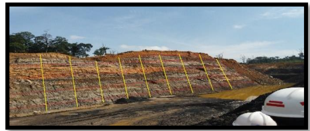
Gambar 10. Scanline titik pengamatan dan pemetaan geoteknik highwall pit SB-II BK-14
