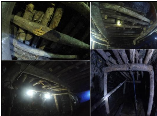
Gambar 9. Kondisi Sistem Penyanggaan Lubang Penambangan Bawah Tanah CBP-03
