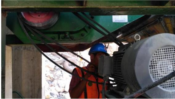
**Gambar 3.** V Belt pada Feeder Lepas
