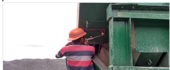
Gambar 2. Pengelasan pada *Chute*
