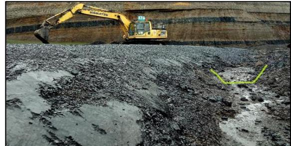
**Gambar 7.** Bentuk actual *drainage* yang baik
