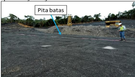
**Gambar 5.** Proses pemasangan pita batas area *cleaning*
