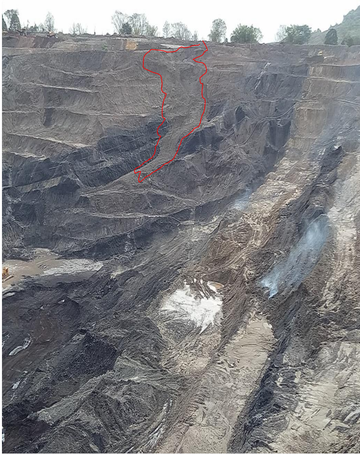
Gambar 3. Foto Keadaan Sekitar Longsor di TAL Barat (terlihat longsor pada garis merah)
