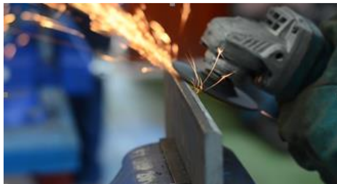
Gambar 2. Pembuatan Groove pada Las SMAW Sambungan las Kampuh V Posisi 1G
