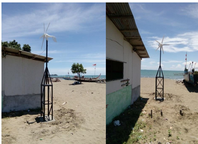
Gambar 1. Pemasangan turbin angin
