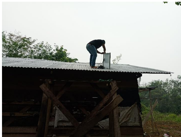
Gambar 6. Pemasangan Panel Surya yang Diletakan pada Atap kandang Puyuh
