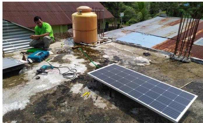
Gambar 6. Pemasangan panel surya
