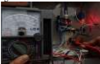
Gambar 16 Pengujian tegangan 12 VDC.
