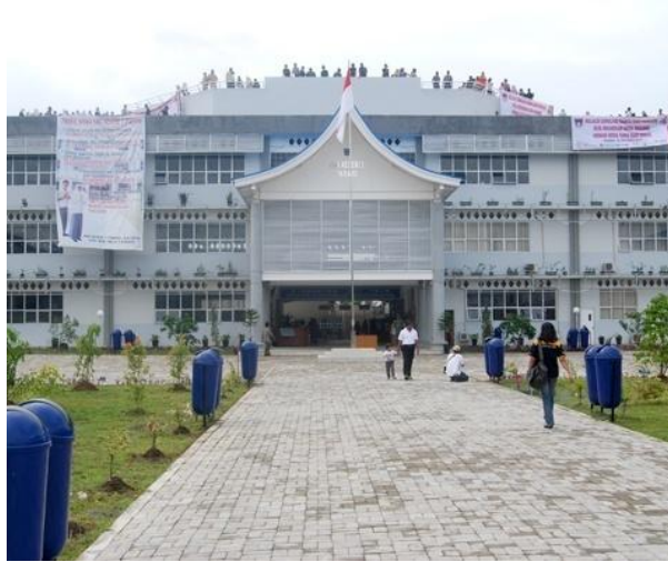
Gambar 3 Bangunan SMA N 1 Padang sekaligus shelter evakuasi tsunami Foto oleh: Angga Rahmadinata
