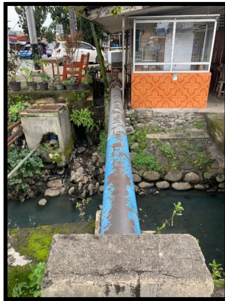
Gambar 4. Pipa PDAM \phi 400 di Kelurahan Flamboyan Baru
