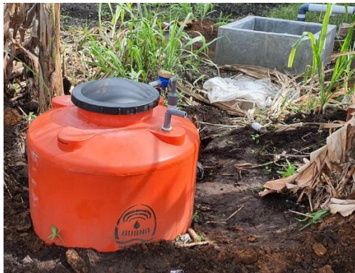
(e). Sumur resapan dan penampung
