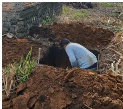
(c). Penggalian sumur resapan
