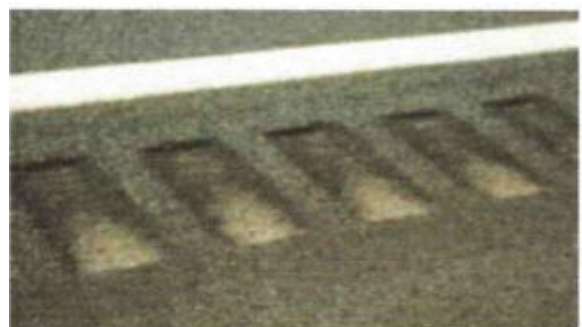
Gambar 4. Pemasangan shoulder rumble
