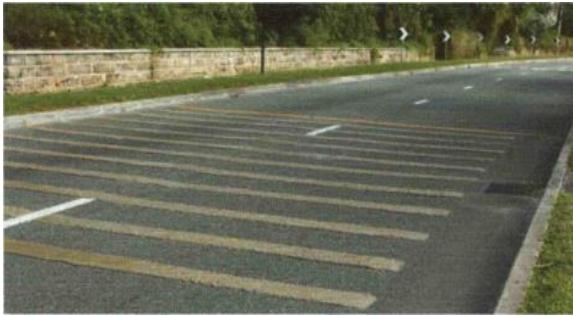
Gambar 5. Pemasangan rumble area
