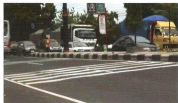
Gambar 3. Pemasangan pita pengaduh ( rumble strips )
