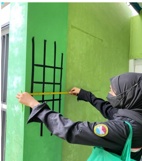
Gambar 1: Hasil Pengecekan Tulangan Dengan Rebar Scanner
