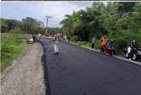
Gambar 1. Perkerasan dan Peningkatan Jalan Gampong Aceh Barat
