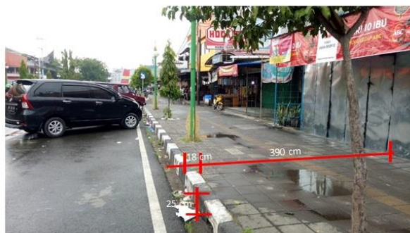
Gambar 3 Lebar Jalur Pedestrian Jl. Ps. Baru sebelah kanan dari simpang empat Jl. Jend. Sudirman (2) (Sumber: Survey Penelitian 2020)
