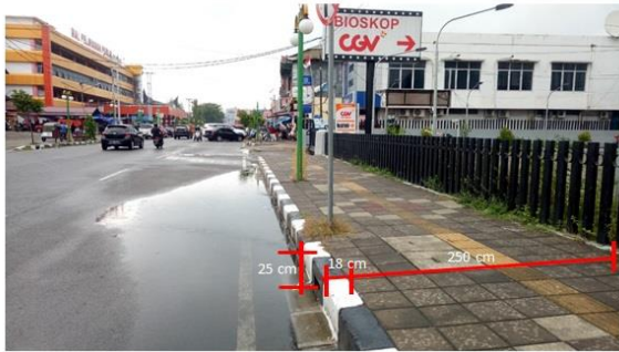
Gambar 2. Lebar Jalur Pedestrian Jl. Ps. Baru sebelah kanan dari simpang empat Jl. Jend. Sudirman (1) (Sumber: Survey Penelitian 2020)
