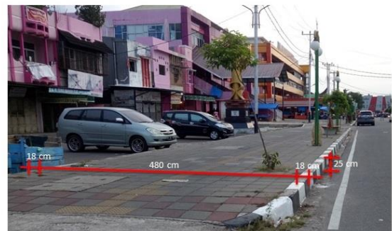
Gambar 1. Lebar Jalur Pedestrian Jl. Ps. Baru sebelah kiri dari simpang empat Jl. Jend. Sudirman
