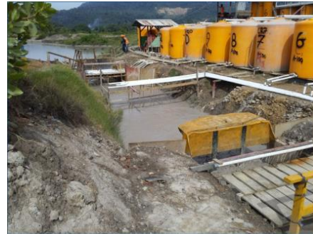
Gambar 8. Injeksi Flokulan pada open chanel inlet WWTP
