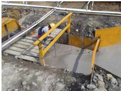
Gambar 6. Kegiatan pengukuran debit inlet WWTP
